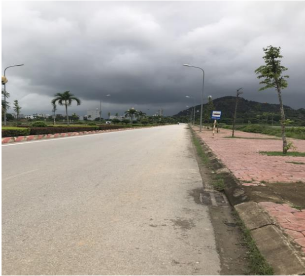
Hình 1.3. Hiện trạng tuyến đường Trịnh Kiểm phía Đông khu vực dự án
